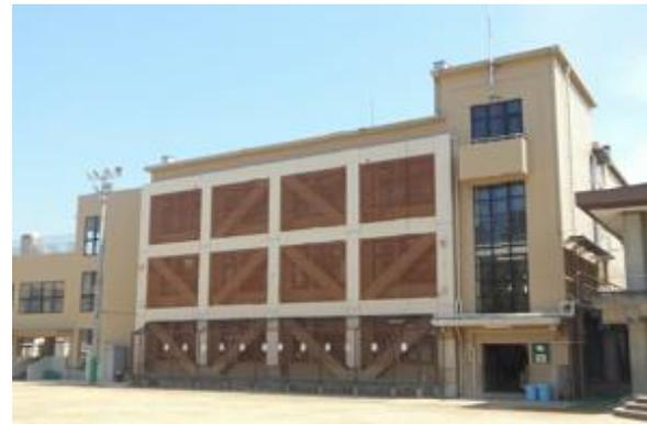
写真⑦ 小学校耐震補強施工例 (大安組提供)
