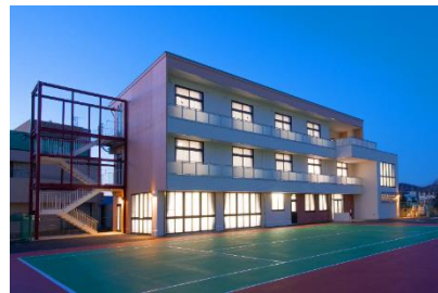
岐阜女子高等学校女子学生寮 新築工事
