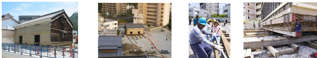
改修前の建築物と曳家作業の様子
