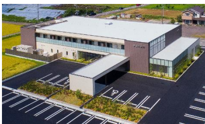
伊佐治医院 新築工事
