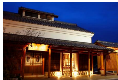
時季の蔵 増改築工事
