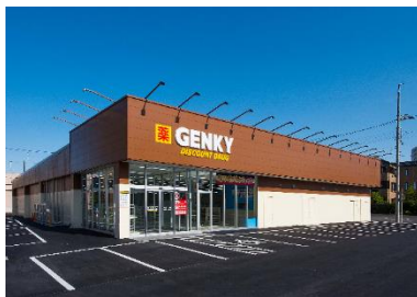
ゲンキー三里店 新築工事
