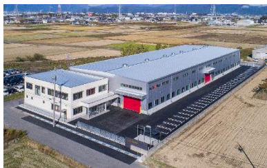
株式会社カオル製作所本巢工場 新築工事
