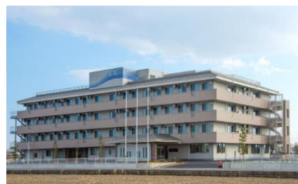
稲沢白寿苑 新築工事
