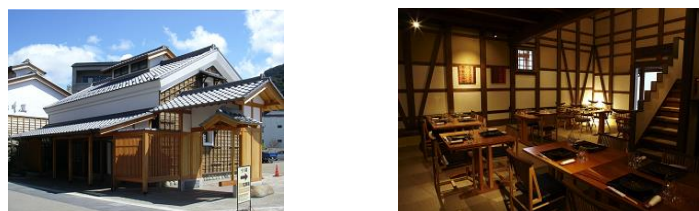
改修後の外観と内部の状況
