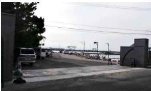
平常時（ゲートは倒伏した状態）
