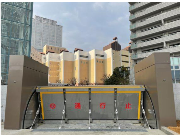
写真⑩ 中神戸地区（自立フラップ式防潮ゲート）
