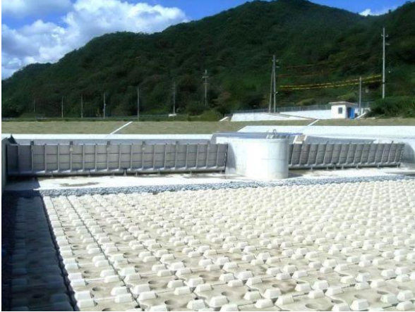
写真⑥ 野間川井堰（トルク軸式ステンレス製起伏ゲート）
