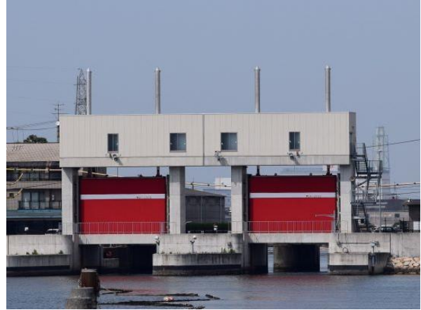
写真⑦ 南水門（鋼板製電動式ローラゲート）
