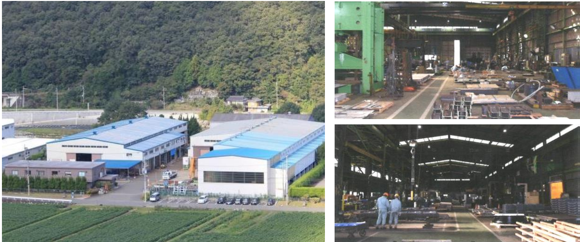
写真④ 左～播州工場全景、右上～第1工場内観、右下～第2工場内観（斉藤鐵工所提供）
