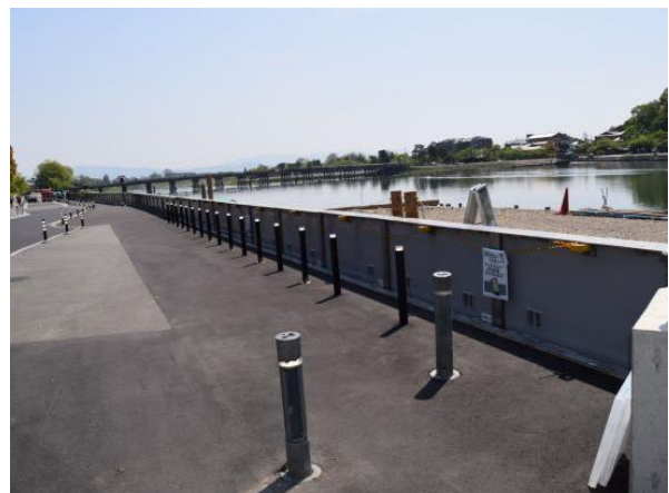
写真⑪ 桂川嵐山地区左岸止水壁（垂直可動式止水壁）
