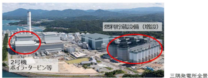
《三隅発電所 2 号機の概要》
