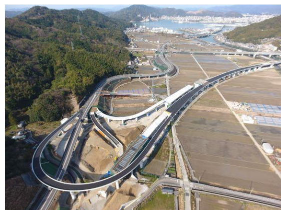
写真9 高知南国五台山地区舗装工事
