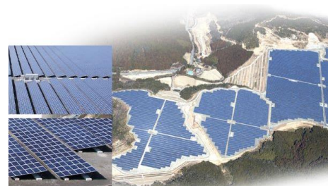
写真32 高知ソーラー発電所 (出典：ミタニ建設工業ウェブサイトより)
