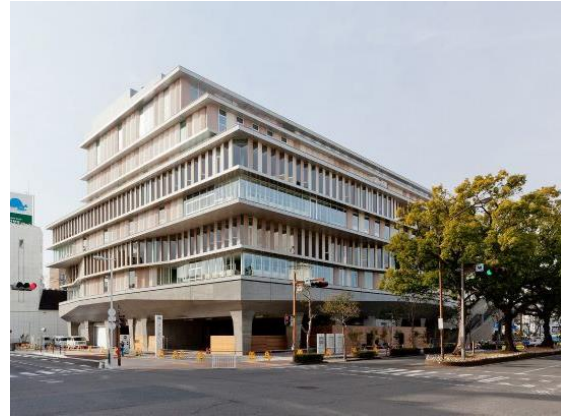
写真5 新図書館等複合施設建築主体工事
