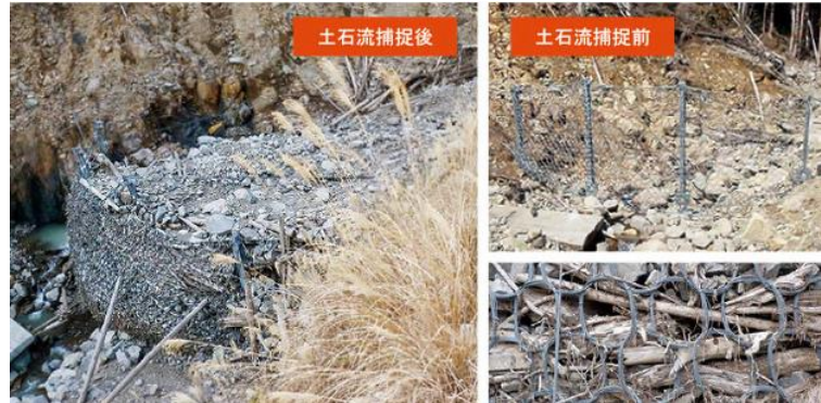
写真11 リングネット落下防護柵による土石流捕捉例 (出典：ミタニ建設工業ウェブサイトより)
