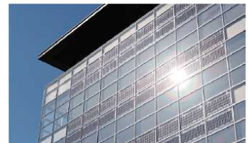
ヒューリック八王子ビル
