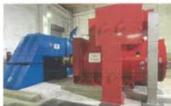
相沼内発電所
