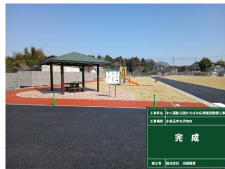
(小川運動公園たちばな広場造成工事)
