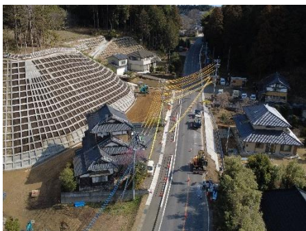
(小美玉市内急傾斜崩壊対策工事)
