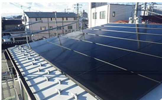
住宅屋根への太陽光設置
