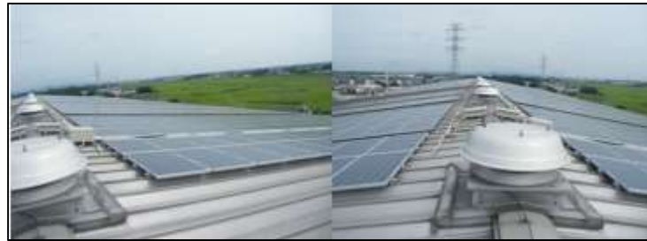
<同社太陽光パネル設置の様子>
