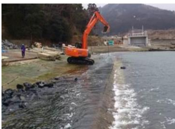
物揚場の復興工事（宮城県）
