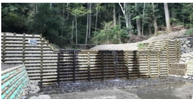
河川復旧工事（静岡県）
