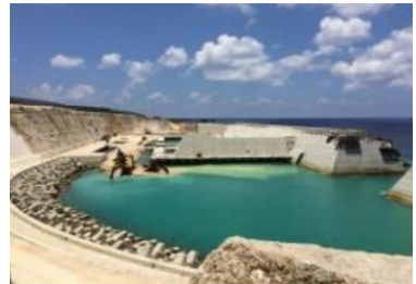
離島の漁港整備（沖縄県）
