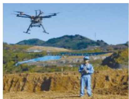
ドローン型レーザースキャナ測量
