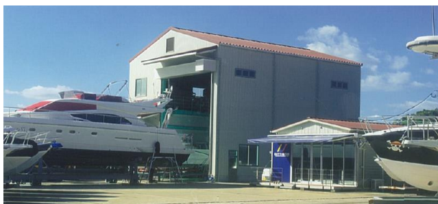
<フィッシャリーナ天草内サービス工場>
