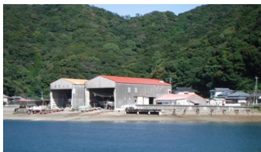
〈熊本システム造船株式会社工場〉
