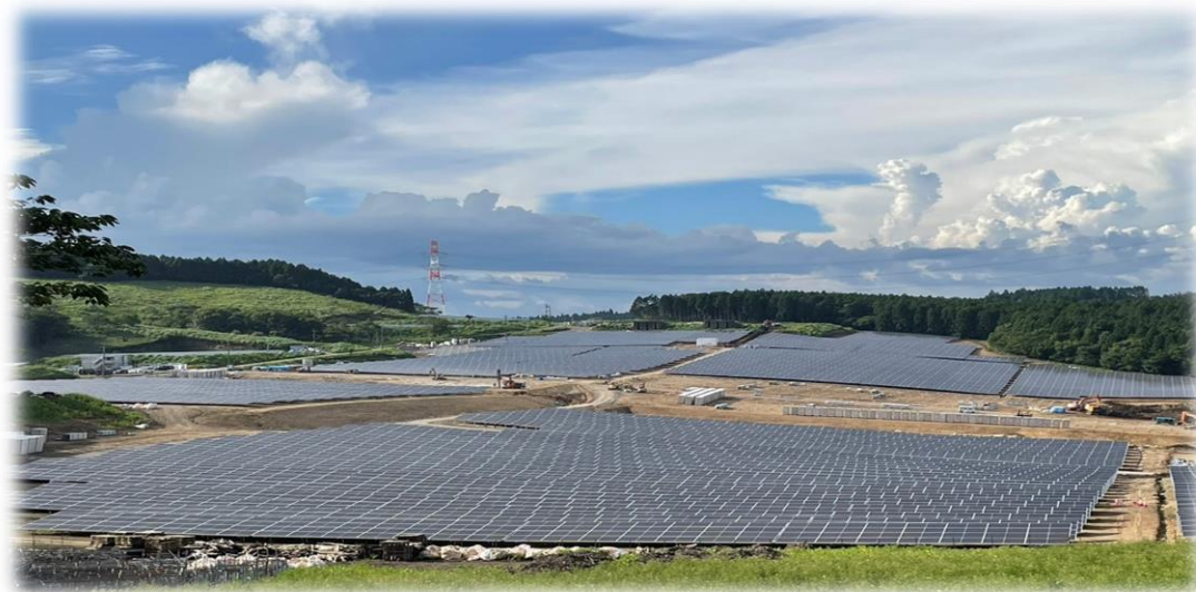
写真上：栃木県内太陽光パネル設置工事 写真下：宮崎県内太陽光パネル設置工事 当社より提供
