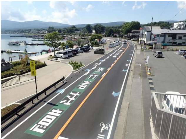
R2 国道 138 号山中地区舗装修繕工事
