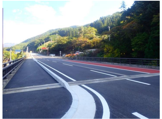
国道 140 号道路改良工事
