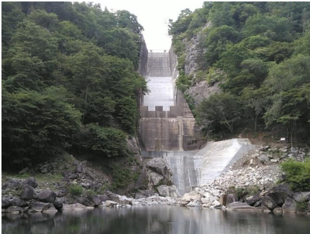
広瀬ダム水吐減勢工改良 I 期工事
