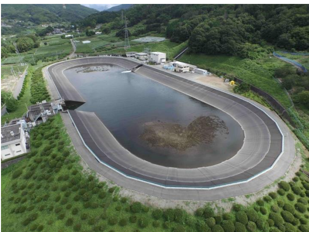
藤木調整池改修工事
