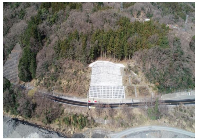
R1 国道 52 号古屋敷地区他災害復旧工事
