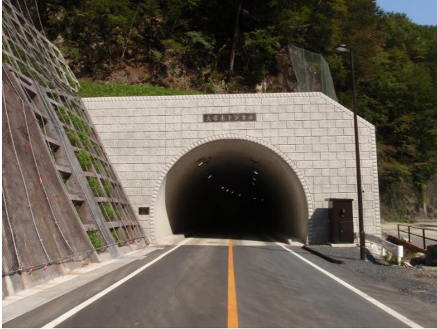
国道 411 号大常木トンネル建設工事
