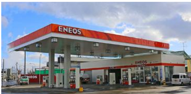
新富町給油所
