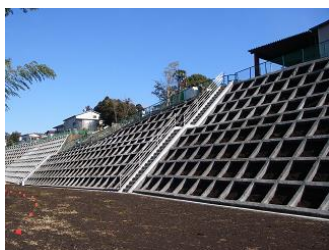
斜面对策工事
