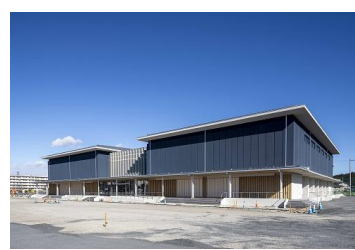
公共施設建築工事
