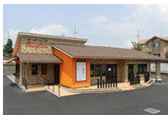
商業施設建築工事
