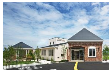
クリニック建築工事
