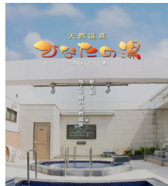
(マンション屋上の温浴施設)
