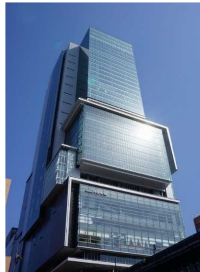
渋谷ヒカリエ (GRC 外壁)
