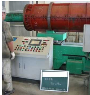
コンクリート投入
