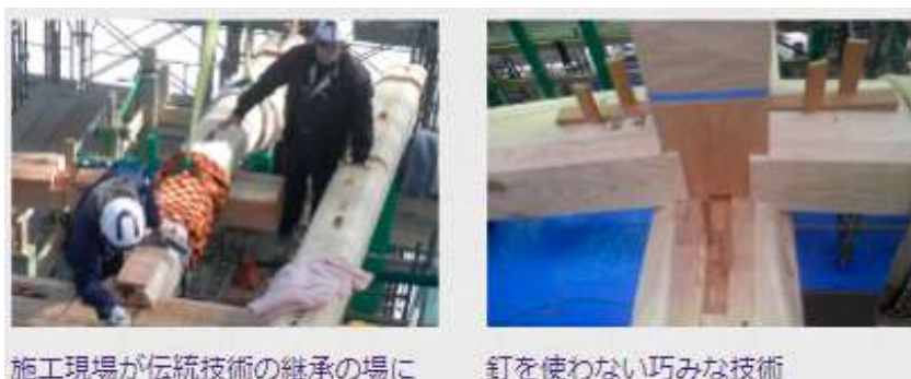
（出所）兼六建設 HP より引用
