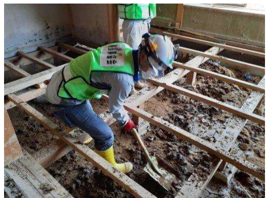
(出所) 兼六建設 HP より引用 / 2022 年の被災地ボランティアの様子
