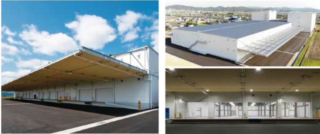
図表4. 第3倉庫の外観
