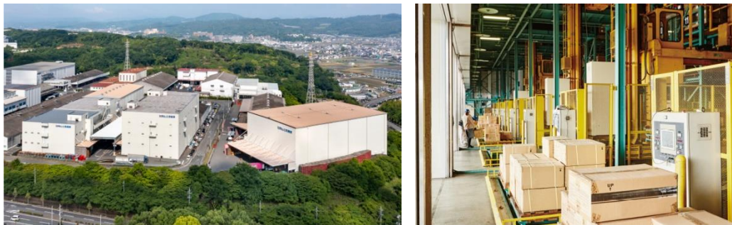
図表5. 流通センター営業所の外観
