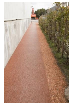
▲ 施工された K-グランド
