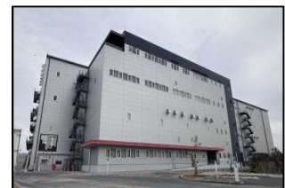
松伏ハブセンター
