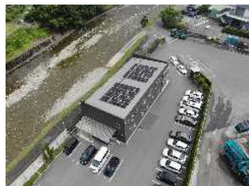
本社屋根に設置した太陽光パネル
