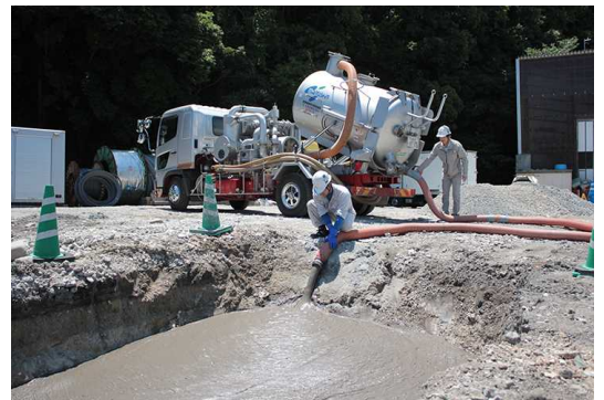
流動化土埋戻作業の風景
