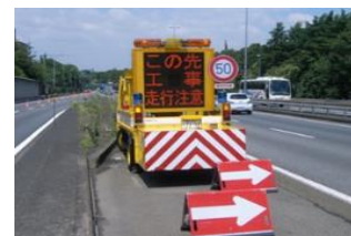
事故復旧工事
