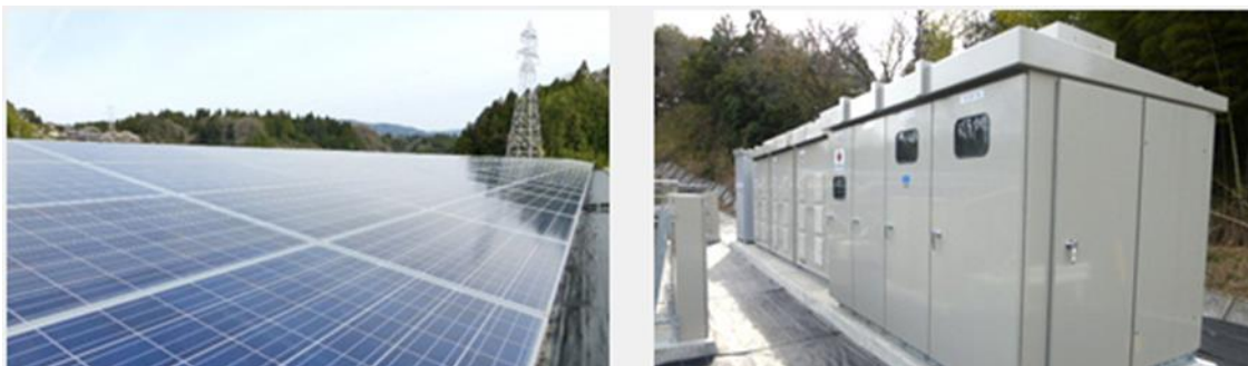
〈太陽光パネルの施工事例〉
