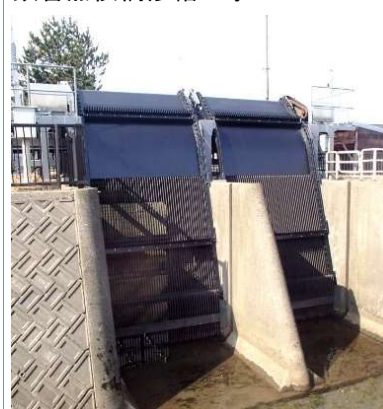
石川県・安産(やすまる)川排水機場機械設備修繕工事
