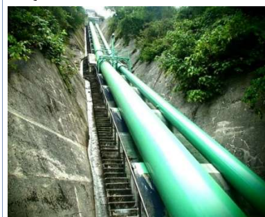
富山県・上市川第三発電所水圧鉄管点検橋修繕工事
