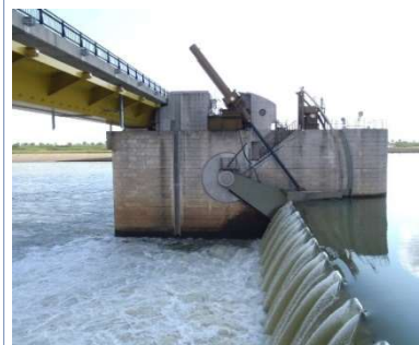
新潟県・大河津可動堰ゲート改良工事
