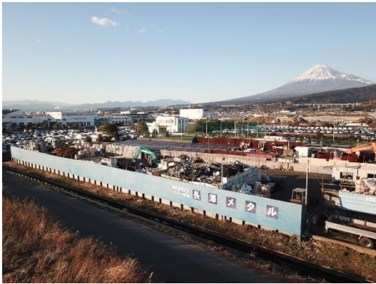
川尻第一ヤード
