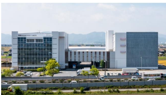
図表 3. 本社営業所の外観
