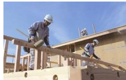
専属大工による施工
