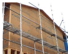
ダイライト施工
