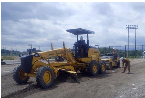
駐車場舗装工事
