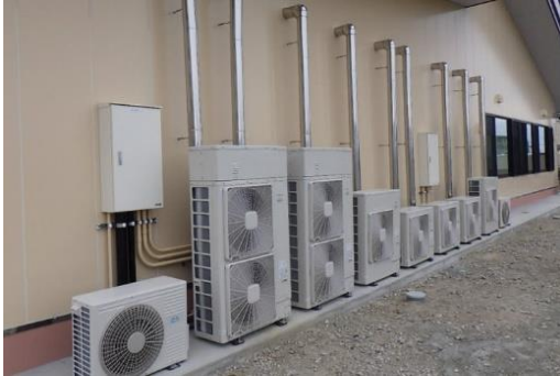
牧田公民館・牧田地区市民センター空調設備等工事
