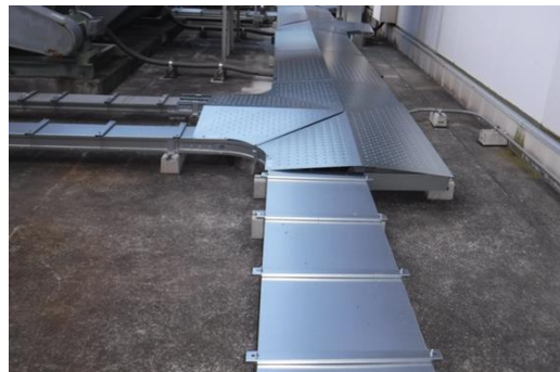
市役所本庁舎電源ケーブル復旧工事
