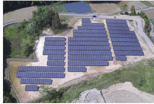
鈴鹿市国分町太陽光発電設備
