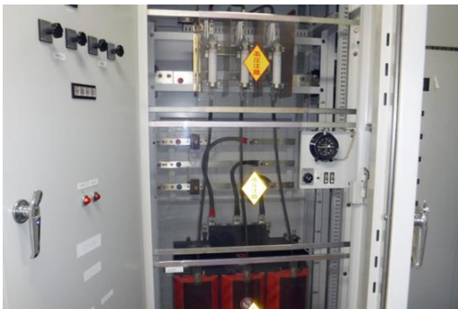
三重県運転免許センター受変電設備改修工事
