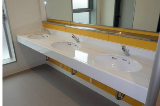
水道庁舎給排水衛生設備等工事
