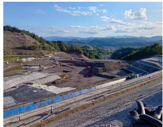
〈最終処分場拡張工事〉
