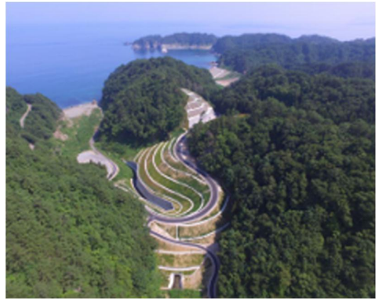
〈道路災害復旧工事〉
