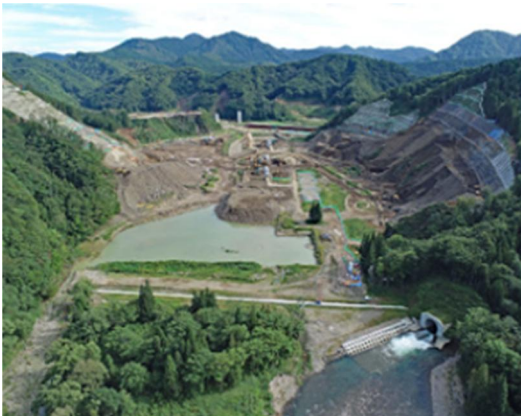
〈ダム建設工事〉
