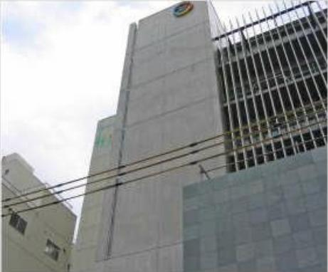
石灰石骨材の特長である低収縮性と単位水量の管理でポンプ筒先まで良好な流動性を保持。ひび割れ、色むら、あばた、コールドジョイントの発生無し
