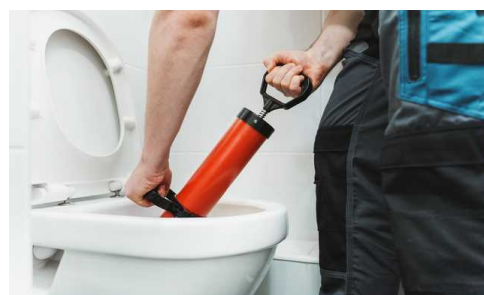
トイレのつまり修理
