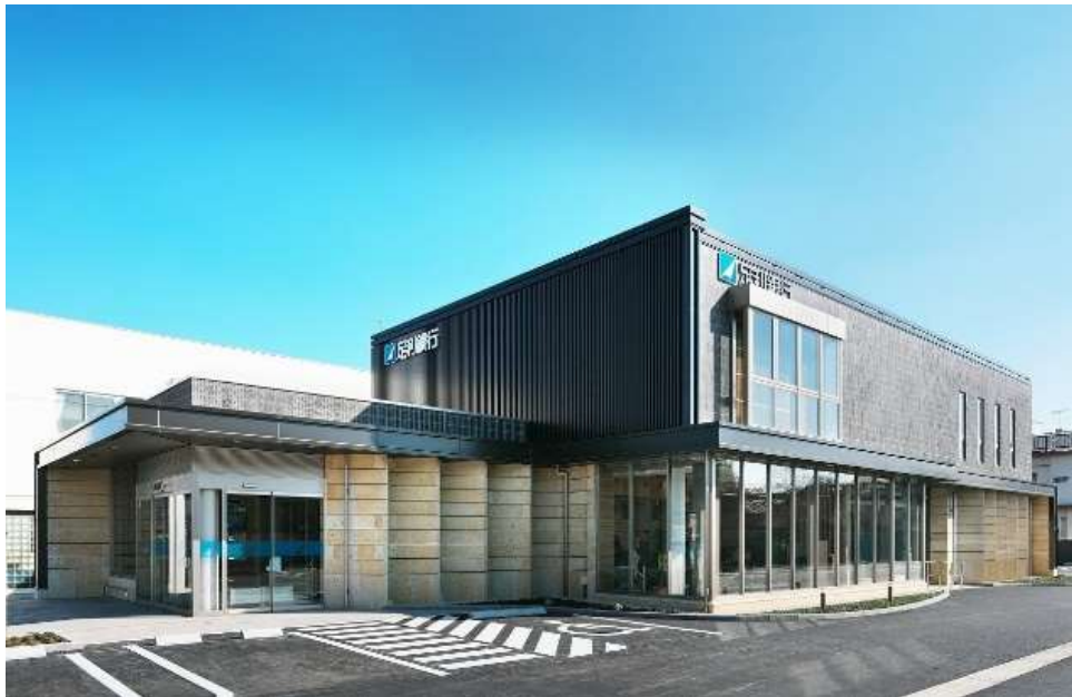
足利銀行 本庄支店新築工事
