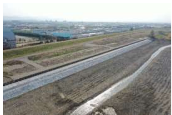
利根川右岸仁手低水護岸災害復旧工事（局長表彰）
