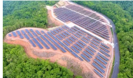
岡山県高梁市 2.9MW
