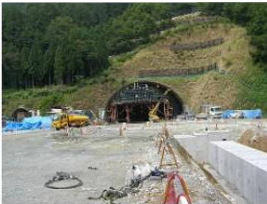
トンネル資材の運搬実績
