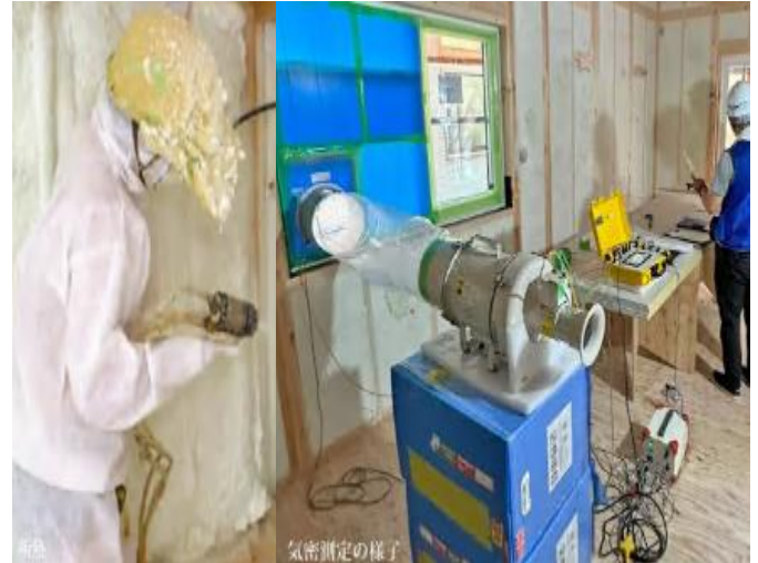
同社の断熱・気密測定の様子。スキマのない家で高い気密性・断熱性を実現している。
