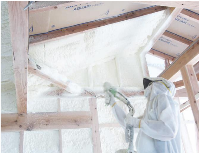
「アクアフォーム」吹付の様子。地球にやさしいウレタンフォーム素材として開発された。
