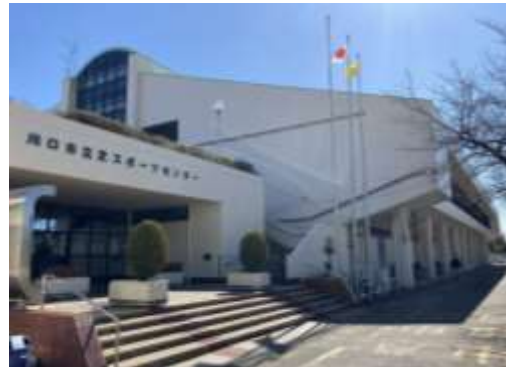
川口市：芝スポーツセンター
