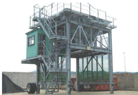
(出所) 伏木海陸運送 HP より引用
