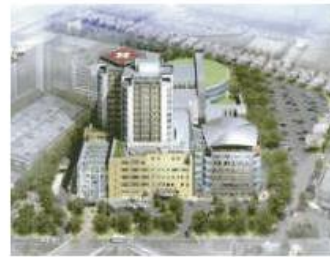
湘南鎌倉総合病院救命センター・外傷センター新築工事現場 〒247-0072 神奈川県鎌倉市岡本1370-1
