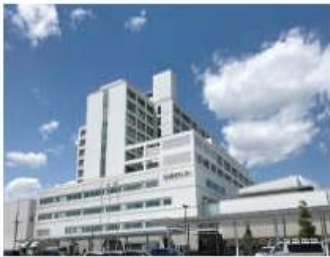
仙台医療センター新築工事現場 〒983-0045 宮城県仙台市宮城野区宮城野2-11-6
