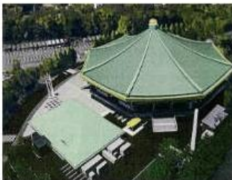
日本武道館増改修工事現場 〒102-0091 東京都千代田区北の丸公園2-3
