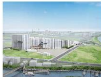
天空橋工事現場 〒144-0041 東京都大田区羽田空港1-10-2
