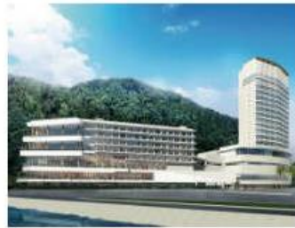
熱海後楽園ホテル工事現場 〒413-0023 静岡県熱海市和田浜南10-1
