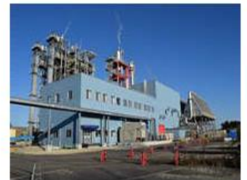
練工フオン新工場新築工事現場 〒321-0215 栃木県下都賀郡壬生町大字壬生乙3451
