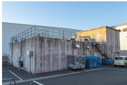
汚水処理プラント
