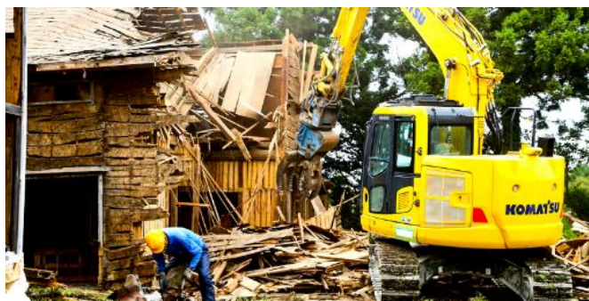
＜解体工事現場＞
