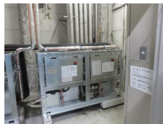
<掛川工場の外観及び高効率なコンデンシングユニット>
