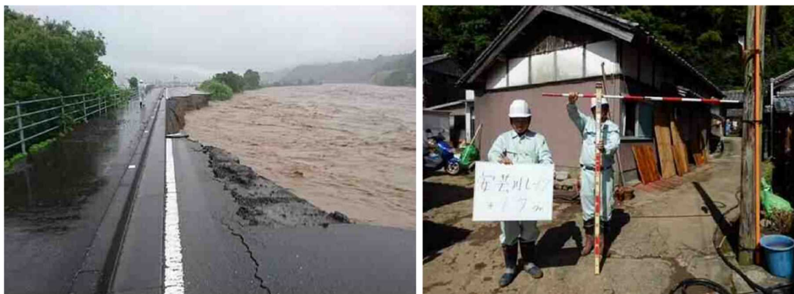
（図5：安芸川 河岸・道路浸食状況（左）、家屋床上浸水状況（右））
