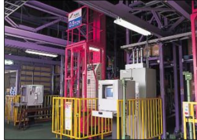
自動ラック倉庫
