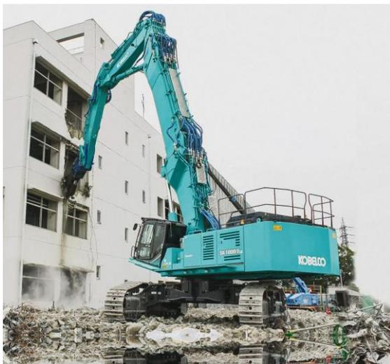
〈KOBELCO SK500,SK550 最大作業高 25m 保有台数 13 台〉
