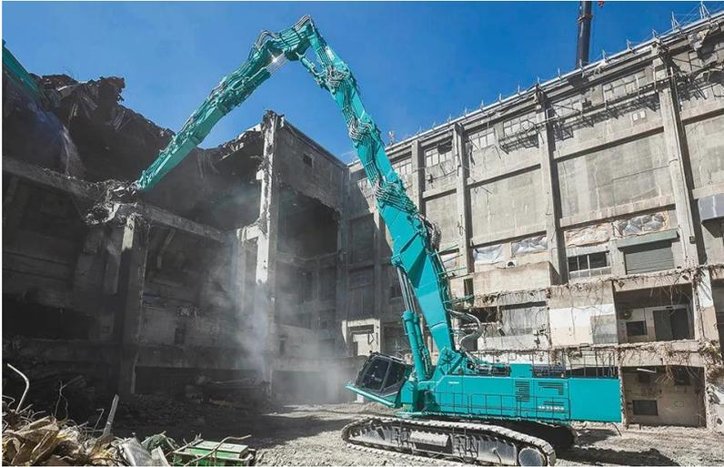
近年は高度経済成長期に建設された高層ビル、基礎の大型化、コンクリート・鉄骨の高強度化などビル解体作業は大規模化が進んでいる。同社が保有する解体用重機の中で最大の重機であるSK2200Dは、最大作業高50mまで対応可能なロングアームと大型基礎・地下構造物の解体に優
