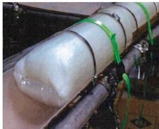
写真：補修材の反転状況
