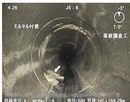
写真：カメラによる管内状況調査
