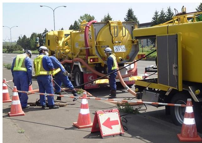
写真：下水道管内高圧洗浄
