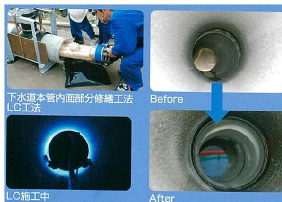
写真：非開削管内部補修(LC 工法)
