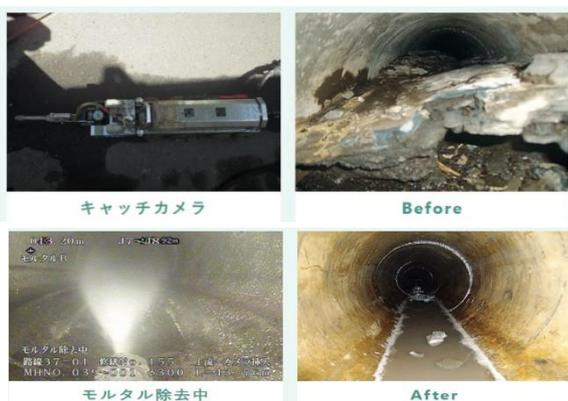
写真：管渠内異物除去作業
