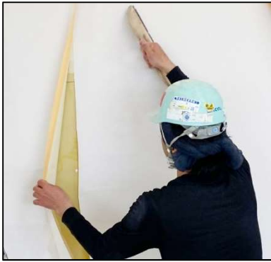
3. <クロス仕上げ工事> シート状の布の 布クロス・紙クロス・ビニールクロスを張る。
