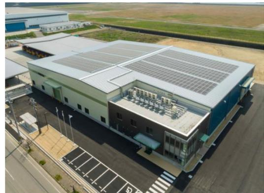
写真⑮ 飾磨工場に設置した太陽光発電設備
