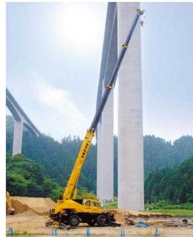
新名神高速道路 池山高架橋工事
