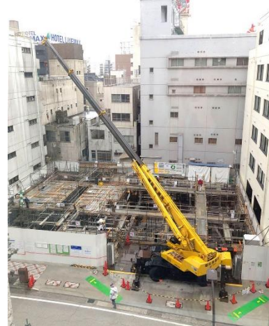
三重県内のマンション工事
