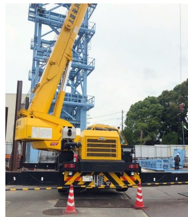
四日市市浜田通り貯留管築造工事
