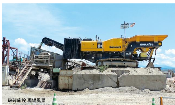
＜アスガラ・コンガラの破碎処理＞
