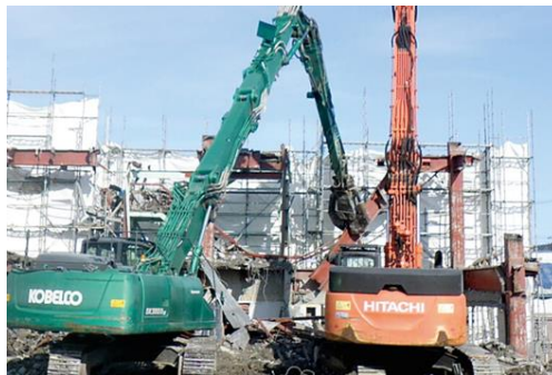
＜解体工事の様子＞
